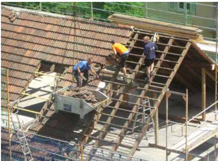
Das alte, undichte Dach wird abgetragen.
