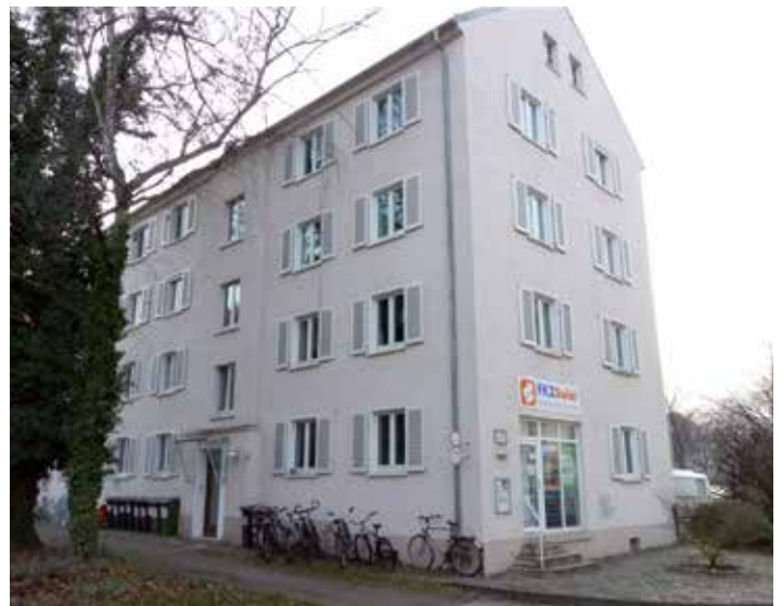
Vor der Sanierung - Ein typisches Mehrfamilienhaus aus den 1950er-Jahren mit überdurchschnittlichem Energieverbrauch.
