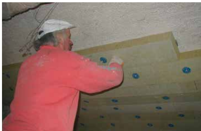
Wenn man gut vorbereitet ist, kann man die Kellerdecke selbst dämmen.
