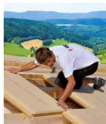
Montage von GUTEX Holzfaserdämmstoff-Platten
