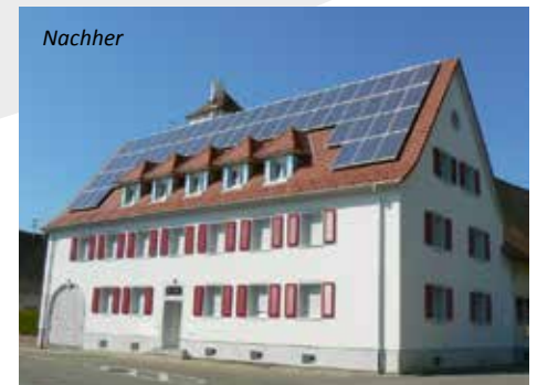
Am Anfang stand auch bei dieser erfolgreichen Sanierung eine Vor-Ort-Beratung.
