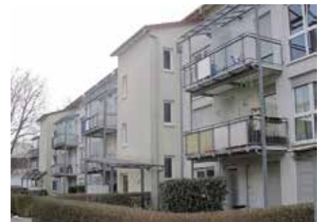
Ein typisches Mehrfamilienhaus braucht eine neue Heizung – welche Lösung ist die richtige?
